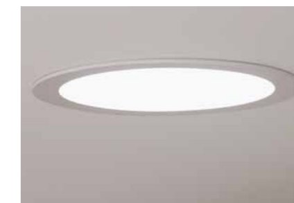
Zakončenie svetlovodu v interiéri.
